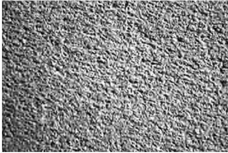
gestockt | bouchardée | bocciardata
